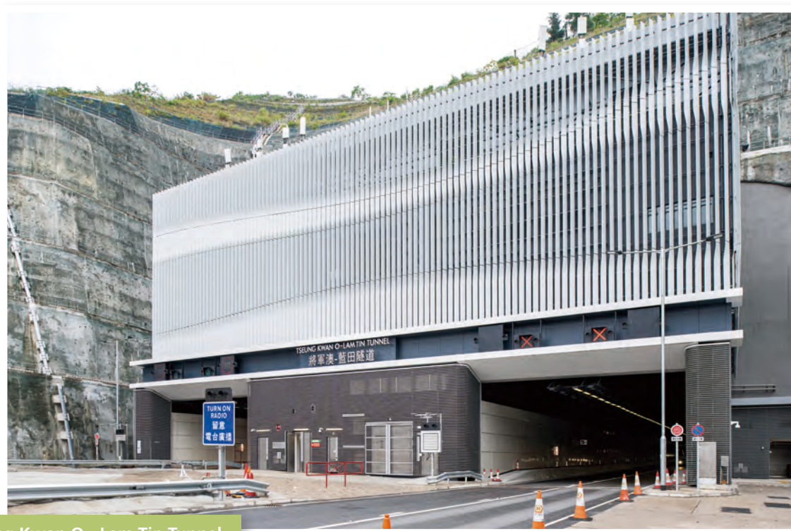
Tseung Kwan O - Lam Tin Tunnel 將軍澳—藍田隧道
