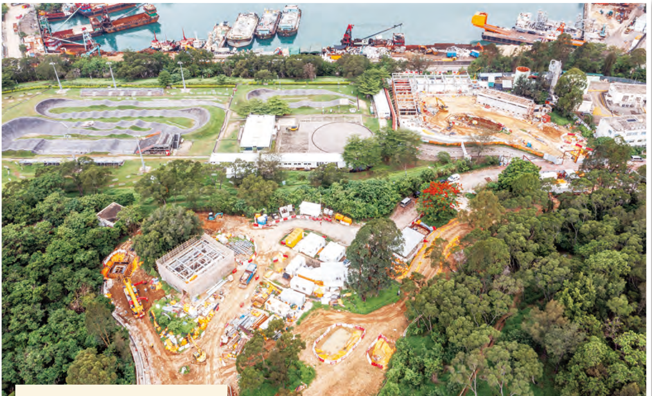
Construction of Kwai Chung Park 葵涌公園的建造工程
