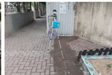
利用噪音計測量地盤所產生的聲音以控制噪音水平
