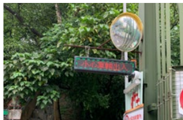
在地盤車輛入口處安裝鏡子及LED顯示屏
