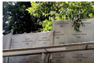
沿地盤邊界設置隔音屏障
