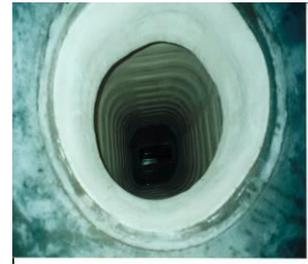
在丽江大研古城片区河道内老旧排水管网提升改造工程EPC总承包项目中，使用离心喷涂修复工艺对河道内渗漏的污水检查井进行修复，修复完成后检查井的结构防腐性能得到了明显的提升。
