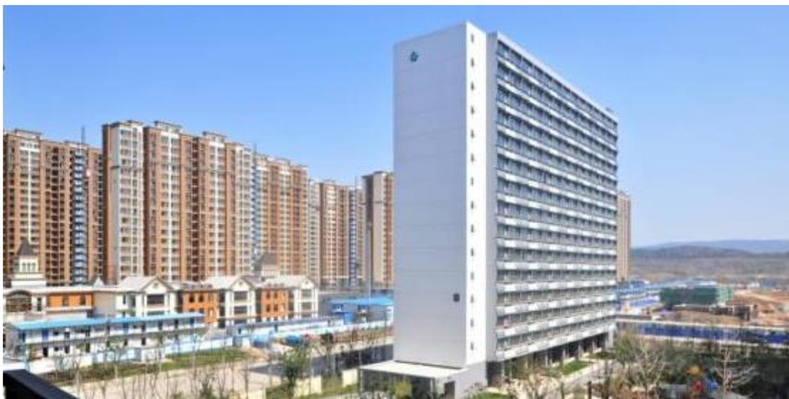
该项目位于南京市江宁区老镇东麟路东与 104 国道之间。建筑结构体系为全预制装配整体式框架——钢支撑结构高层建筑。
