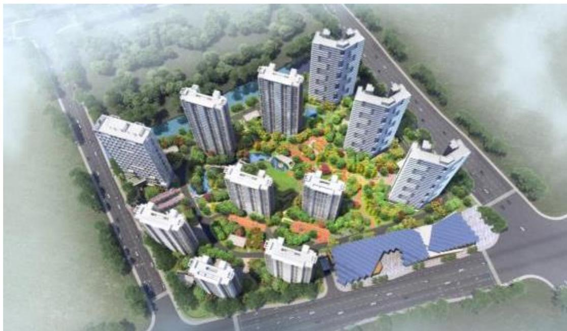
该项目位于南京市江北新区健康城，高层住宅结构均采用装配式混凝土剪力墙结构；3号楼（未来居住建筑）采用装配式组合结构（装配式钢框架+现浇混凝土核心筒），是江苏省第一栋装配式组合结构的居住建筑；12号楼社区服务中心采用装配式木结构，是我国第一栋木结构的零碳建筑。装配式建筑全技术体系在该项目中全方位的得到了创新应用。
