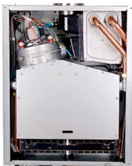
二次换热结构（烟气回收型）
