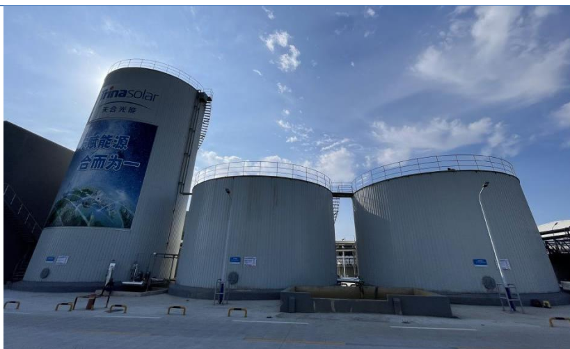
（天合光能科技（盐城）有限公司 16GW 高效太阳能新能源废水污水处理及达标排放项目）
