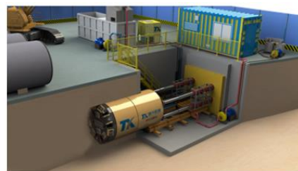
3、启动主机挖掘前方岩土，控制油缸伸出，将主机推入岩土内
