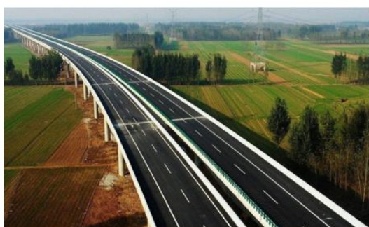
广元-平武高速项目——S95矿渣粉
