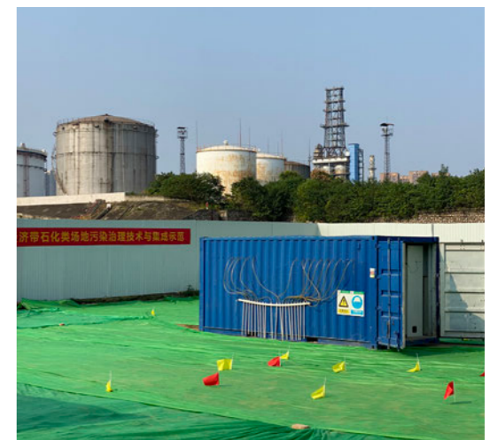
在役石化场地绿色修复技术与装备体系中韩（武汉）石化示范场地施工
