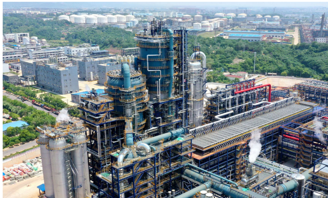
安庆石化重油催化裂解装置
