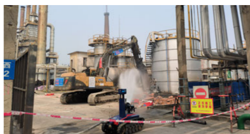
消防坦克拆除作业
