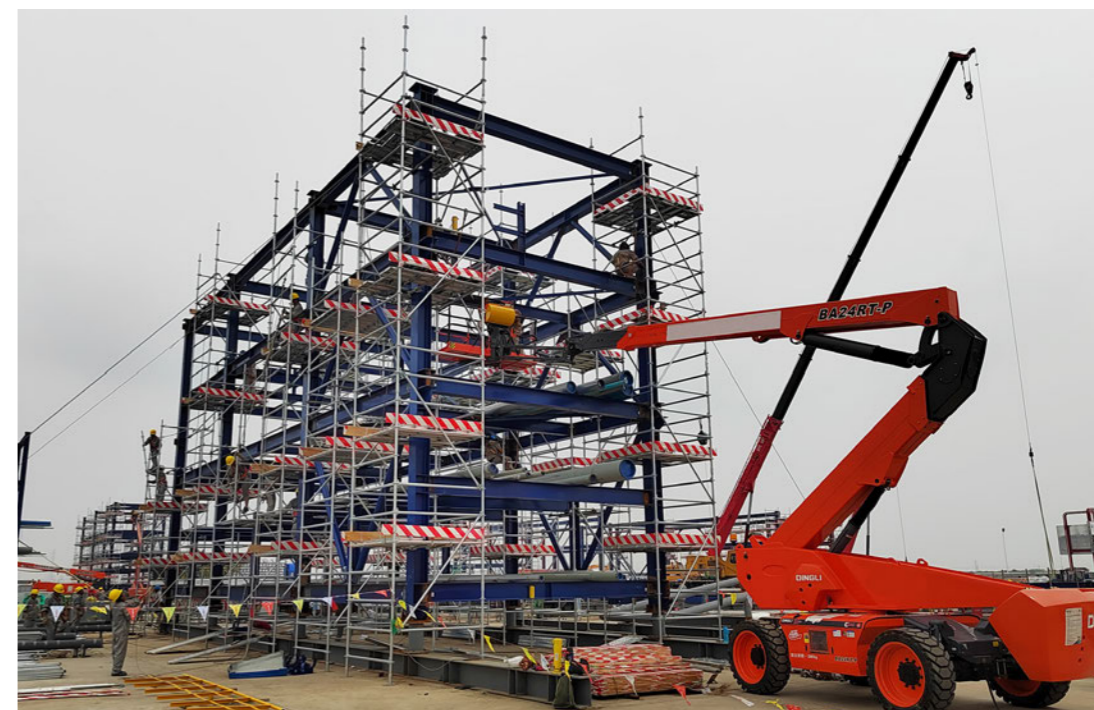
南港乙烯工艺管廊模块建造
