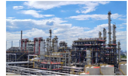
CHP 法制环氧丙烷装置
