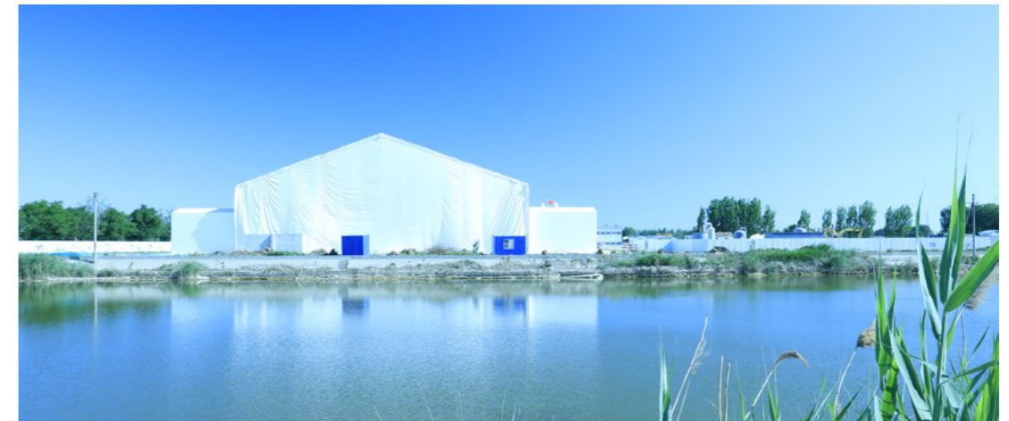
大黄堡湿地保护区的土壤及地下水修复项目
