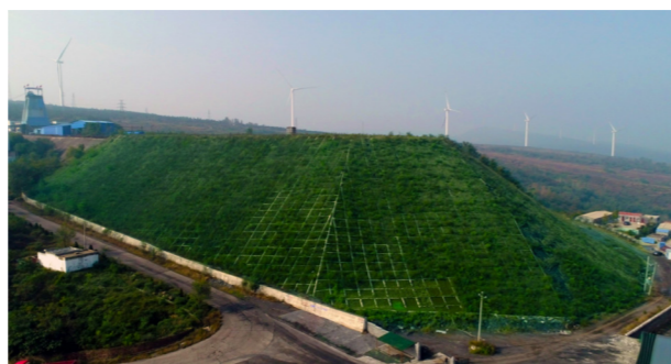
• 四矿矸石山绿化工程
