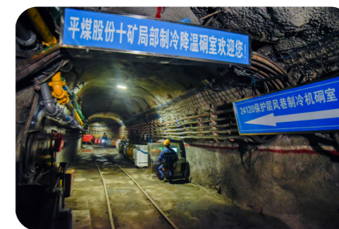
● 十矿局部制冷降温硐室技术达到国内领先水平，成为河南省一流的矿井降温工程，改善职工作业环境。
