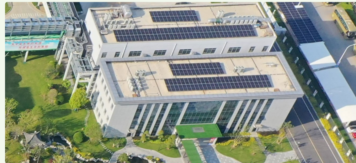
屋顶光伏发电
