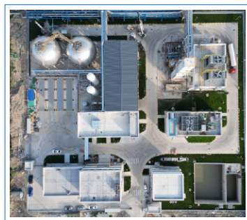
▲ 嘉兴金宏碳捕捉建设项目
