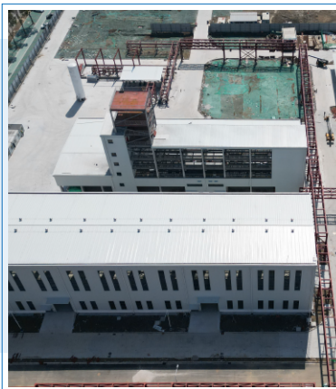
▲ 新建高端电子专用材料项目
