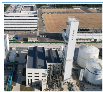
▲ 新建电子级氮气、电子级液氮、电子级液氧项目
