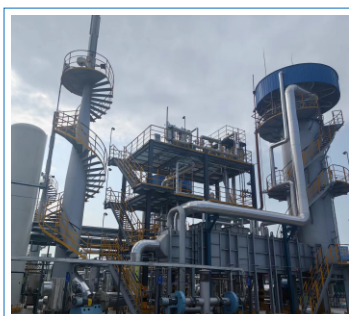
▲ 制氢储氢设施建设项目
