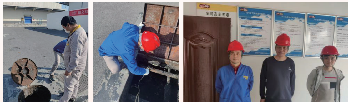
污水泄漏事故突发事件处理演练现场
