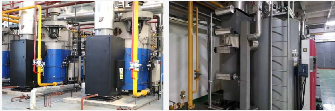
宝鸡公司（左图）、闵行公司（右图）开展锅炉省煤器优化
