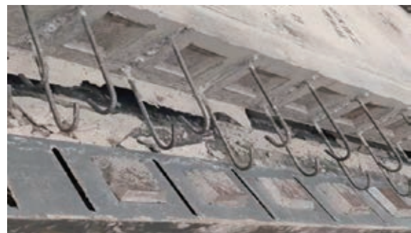
圖2：剪力鍵替代粗糙面工藝
