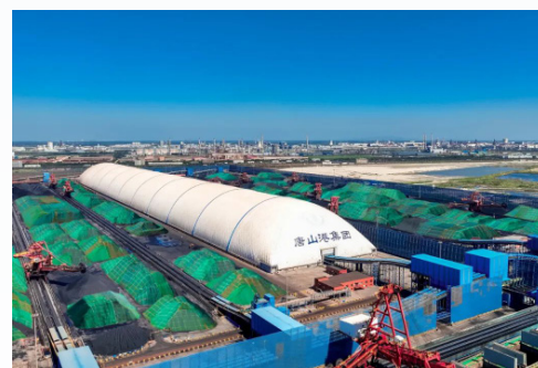
气承式膜结构条形仓建成投用
