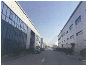
估价对象内部
