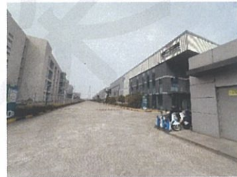
估价对象内部
