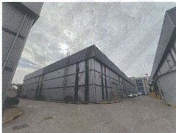
估价对象内部
