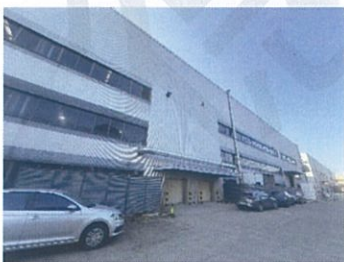
估价对象内部
