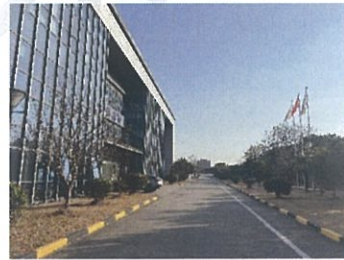
估价对象内部
