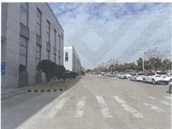
估价对象内部
