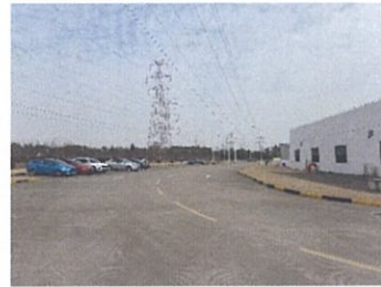
估价对象内部
