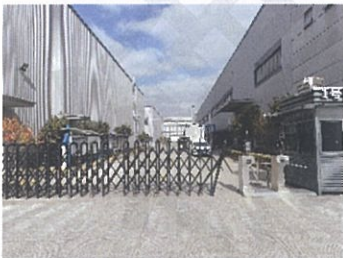
估价对象内部
