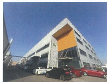
估价对象内部
