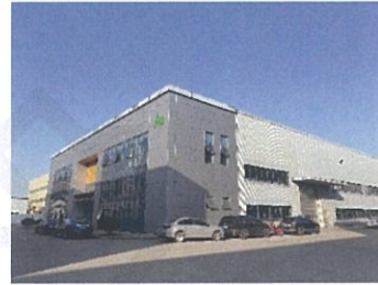
估价对象内部
