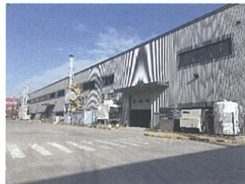
估价对象内部
