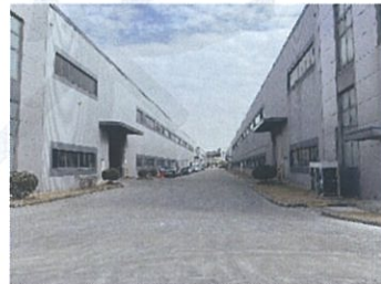
估价对象内部
