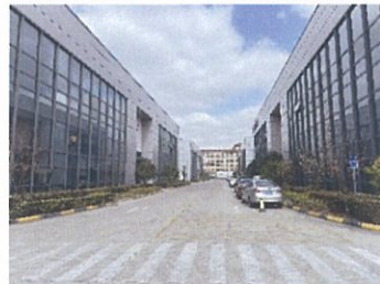
估价对象内部
