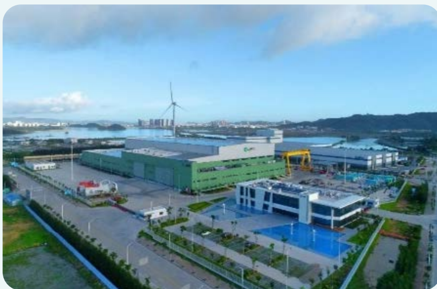
汕头智慧能源示范项目
