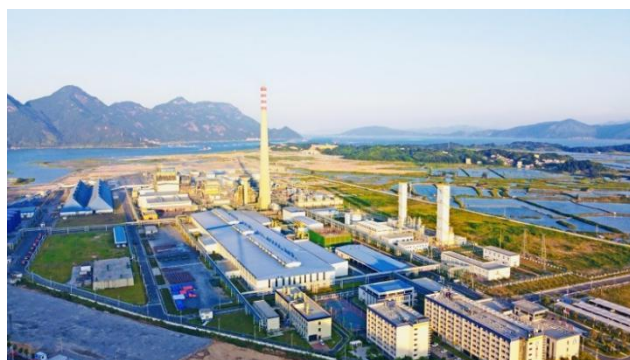
东南铜业厂区
