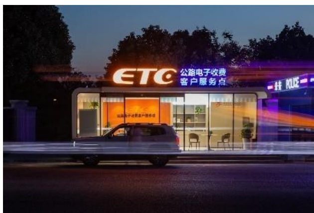
焕新升级的滁州南站综合服务站
