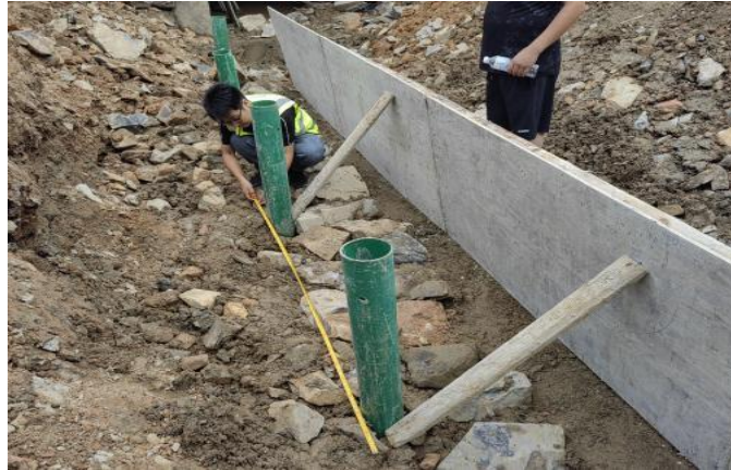
废旧护栏用于边坡支挡防护
