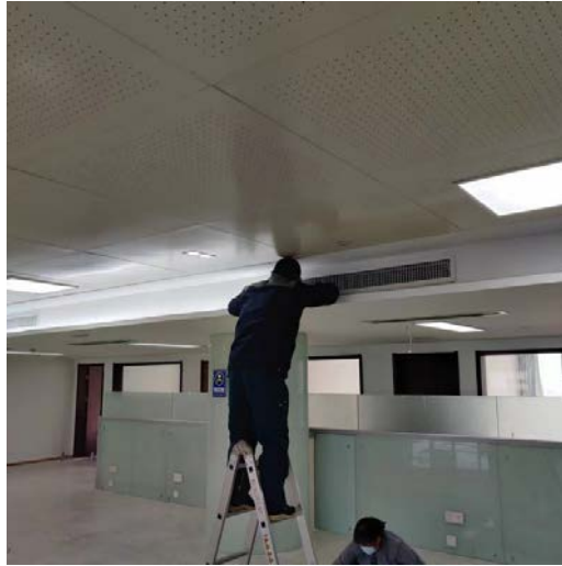
施工人员更换节能灯具
