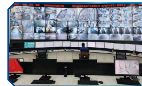
億噸砂智能工廠（中控室）
