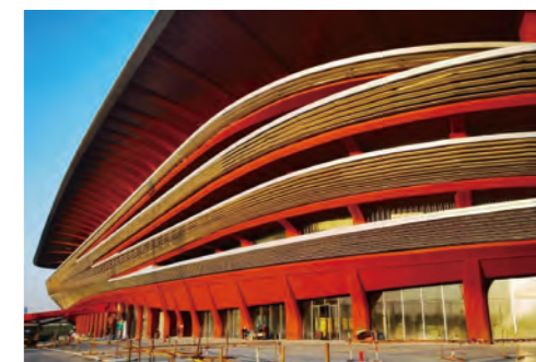
華新超可隆® 超高性能建築幕牆板應用於西安國際足球中心
