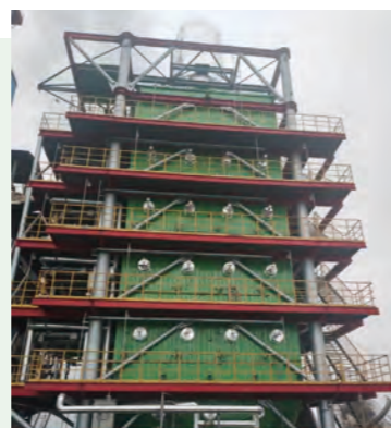
大冶公司高效 SCR 脫硝系統
