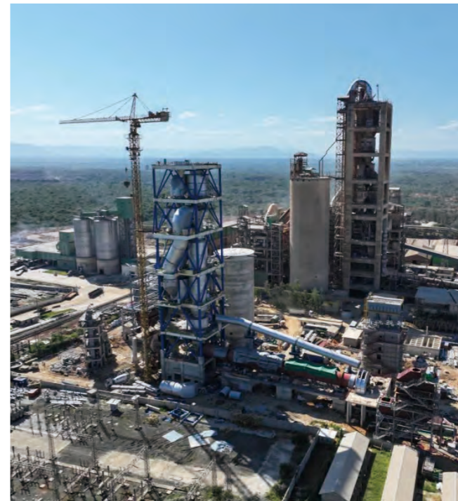
2023 年 9 月 28 日，華新坦桑尼亞馬文尼公司二期新型幹法生產線項目預熱器安裝順利封頂，已於 2024 年 1 月建成投產
