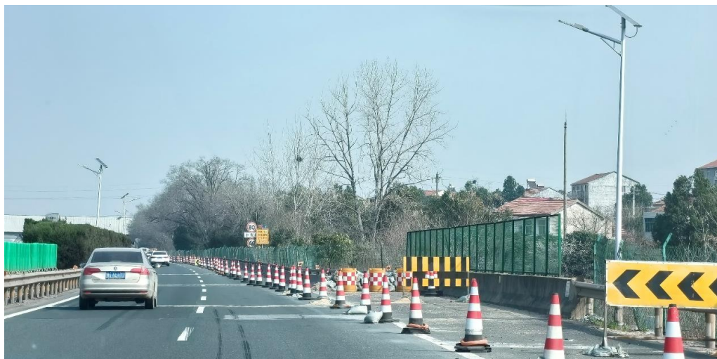
图 3.1-11 京港澳高速湖北北段占道施工
