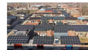
上海源焯安徽户用光伏项目
