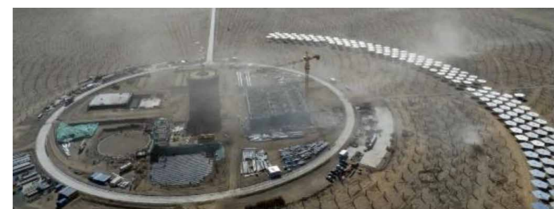
甘肃阿克塞光伏 + 光热建设项目
