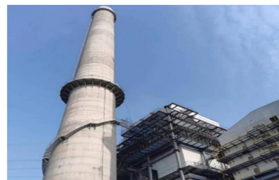
新一烧 360 平烧结机脱硫脱硝
