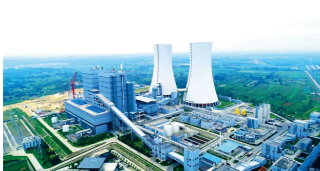
公司产品应用于国家火电示范工程安徽平山电厂二期项目
