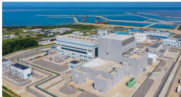
公司产品应用于全球首座第四代核电技术商业化的示范项目山东石岛湾核电站
