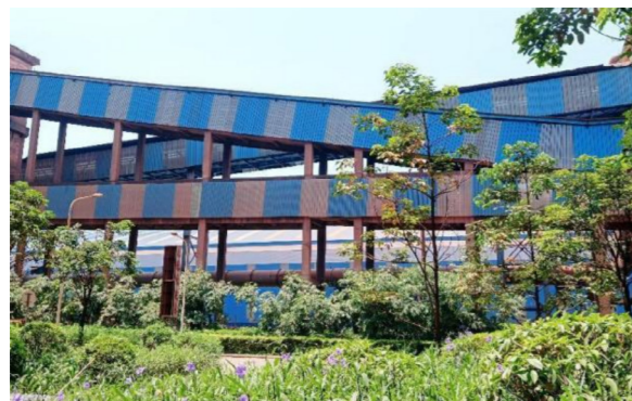
皮带通廊封闭
