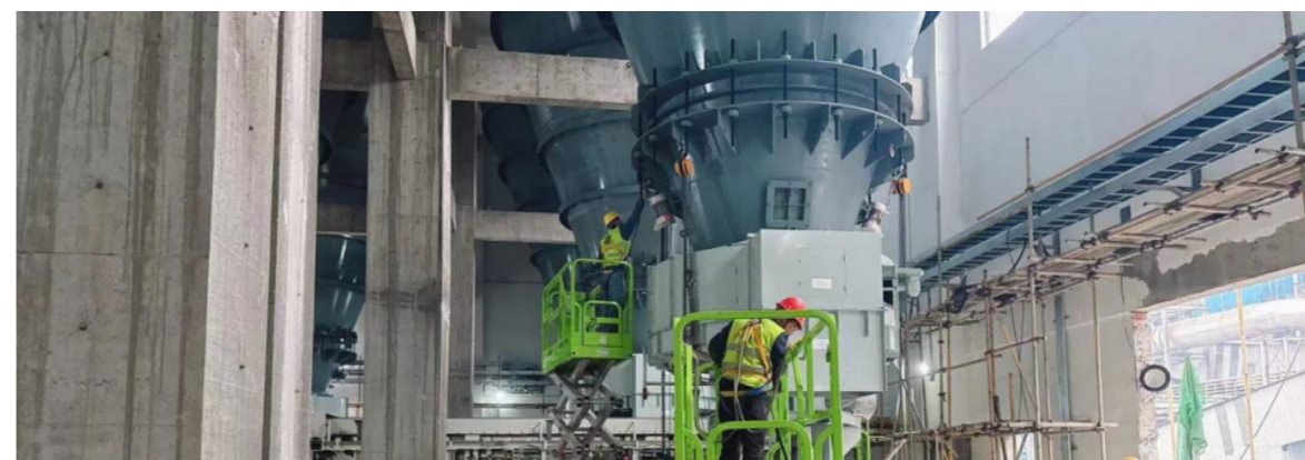
铁前原料场环保改造项目
