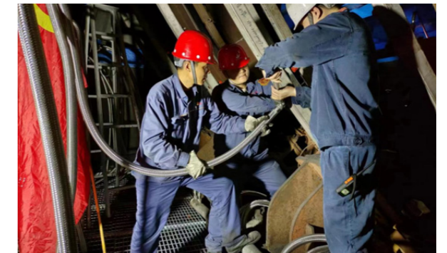
阳春新钢炼铁厂党支部让党徽闪耀在大修一线
