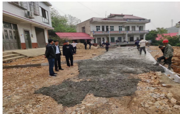
VAMA对安全隐患路段进行拓宽硬化改造
