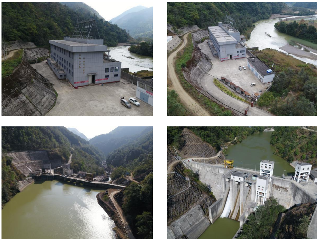
图 8 松山河口水电站项目厂房及大坝外景图
