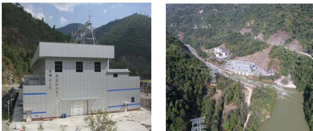
图 6 苏家河口水电站项目厂房及大坝外景图
