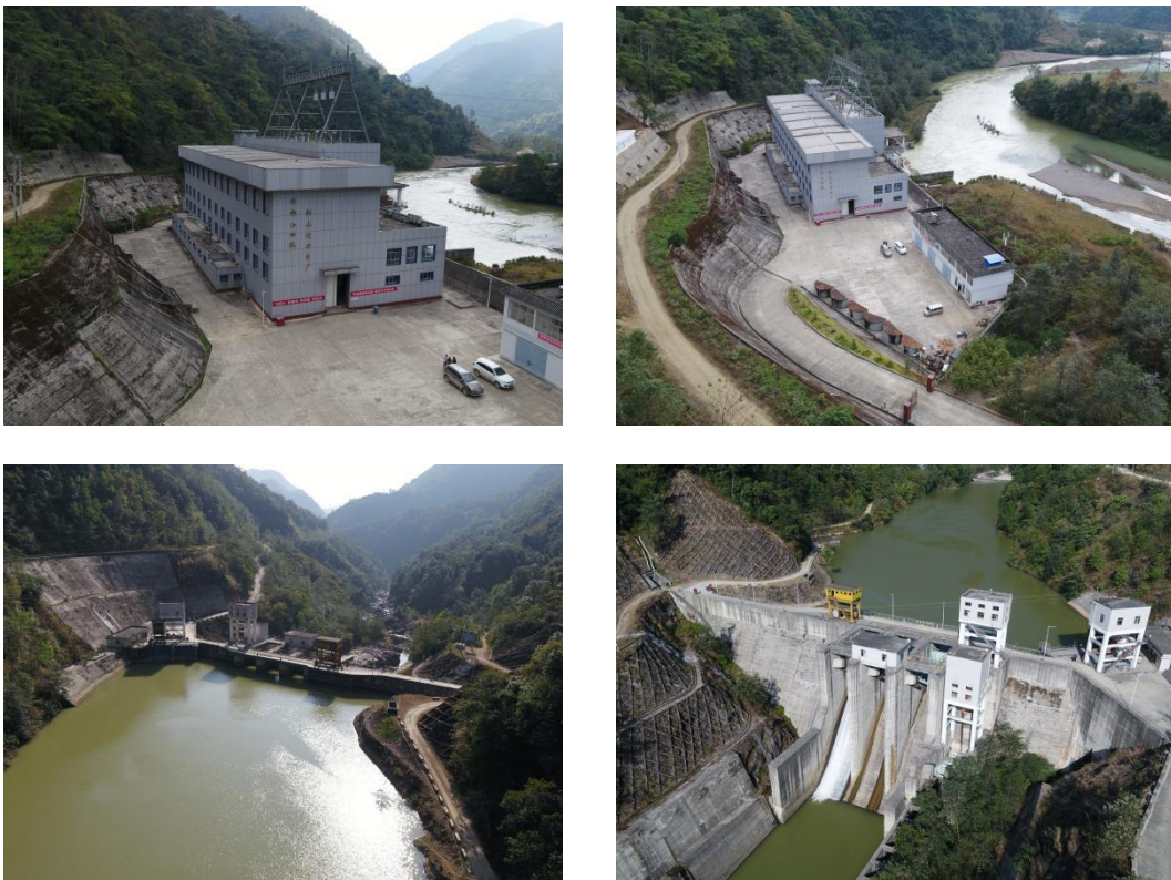
图 7 松山河口水电站项目厂房及大坝外景图
