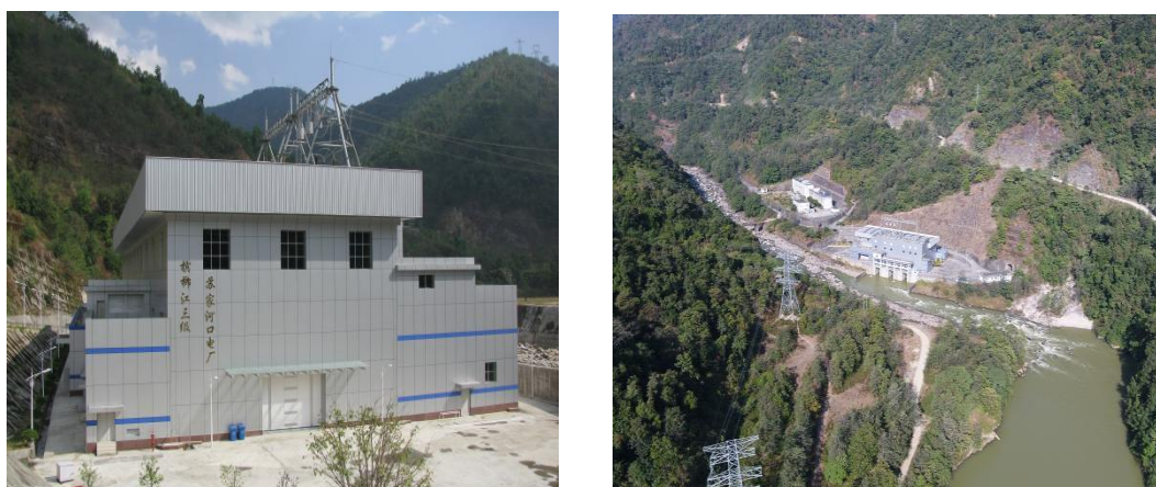
图 7 苏家河口水电站项目厂房及大坝外景图
