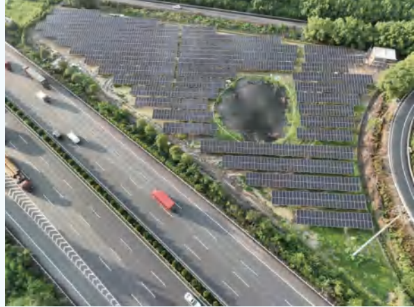
杭甬高速寧波段大隱互通區光伏項目
