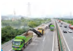
湖州管理中心實施杭甬高速南莊兜至德清段專項集約化施工
