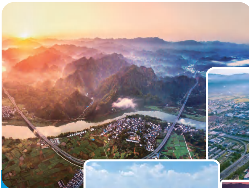
徽杭高速雄村段
