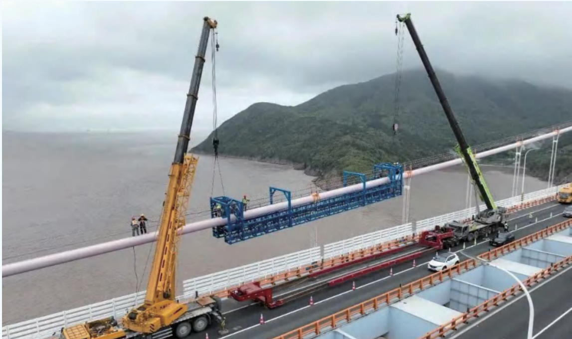
西堭門大橋施工現場
