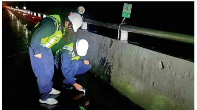
巡查員在牟山湖大橋檢測橋面溫度，確保現場不出現結冰和積雪情況
