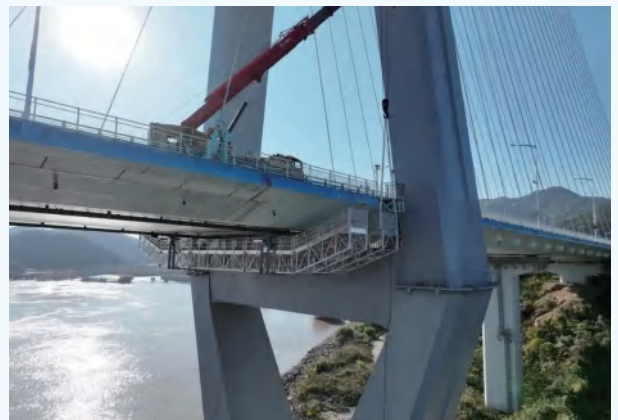
舟山管理中心在桃天門大橋投入使用新型梁底檢查車，採用全自動控制，具有準確、安全、環保、無噪音、無污染等特點
