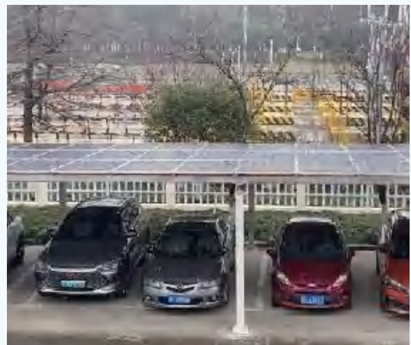
嘉興東收費站利用屋頂、車棚、閒置空地佈設風光儲充一體化綠色能源，建成公司內首個低碳收費站
