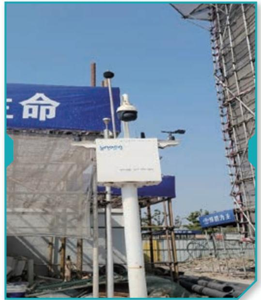
在建築地盤安裝分貝測量儀，監控噪音水準，每日進行數次隨機檢查，不定時記錄度數。
