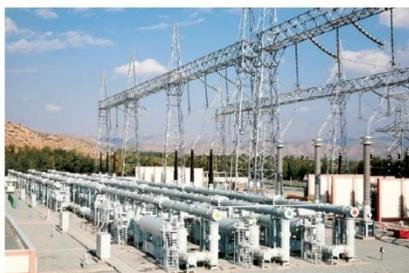
▲ 国内首套 800kV GIS 产品应用于我国首条 750kV 输变电工程—官亭变
