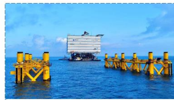
如东海上柔直工程换流站
