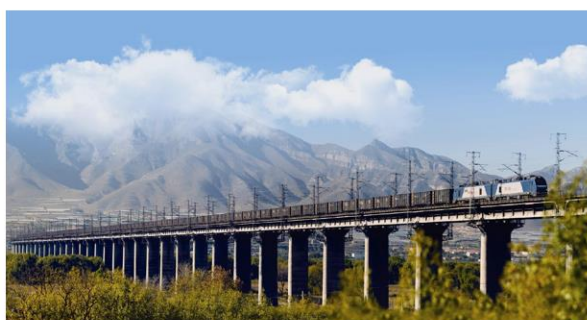
奥特迅功率融通装置应用于**铁路 (国家级电气化重载铁路，我国西煤东运大通道)
