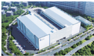
2 深國際公路樞紐物流港 (深圳寶安)
