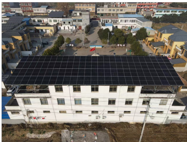
新野光伏樣板工程
