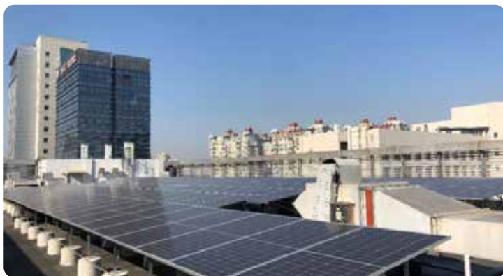
太保產險 929 園區完成低碳節能改造工程
