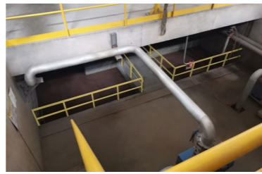
喷漆车间污水收集池
