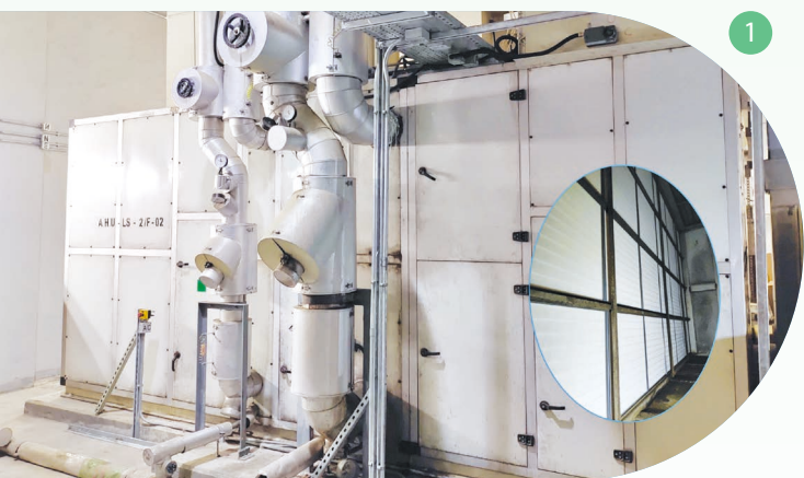
1. 採用納米技術低能耗、高效能空氣過濾系統，以改善室內空氣質素表現
