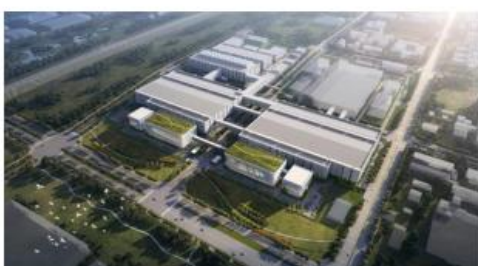
长鑫集成电路 (二期) 生产厂房项目
