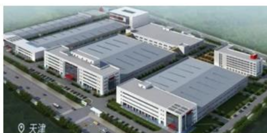
纳通总部大楼弱电智能化系统运维服务
