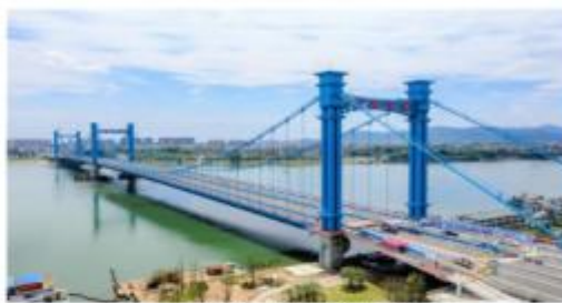
图例：襄阳凤雏大桥
