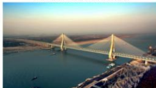
图例：天兴洲长江大桥
