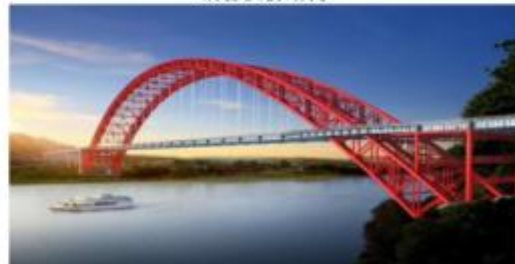
图例：四川犍为岷江特大桥
