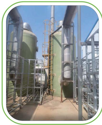
在脫硝劑的製造工序中，混煉及烘乾過程會產生少量粉塵，而陳化和焙燒工序則會產生粉塵、二氧化硫和氮氧化物。固安迪諾斯所有生產工序的排氣口均設置布袋除塵器及噴淋塔等廢氣處理設施，確保廢氣達到《大氣污染物綜合排放標準》(GB 16297-1996)或《工業爐窯大氣污染物排放標準》(DB13/1640-2012)的要求後方可進行排放，嚴禁不經處理直接排放。
