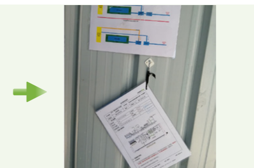
污水处理站隐患整改后 (张贴安全操作规程)
