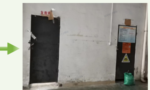
危废仓库隐患整改后 (杂物移除)
