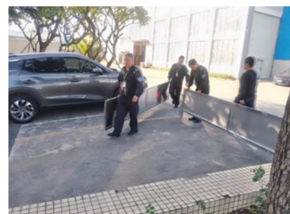
应对极端天气演练 - 在地下车库口 安装挡板挡雨水
