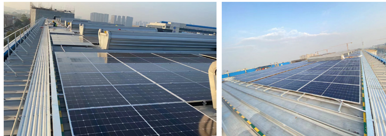
安装光伏设备
