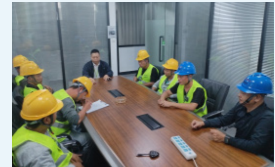
南沙基地（C栋）光伏安装工程安全培训
