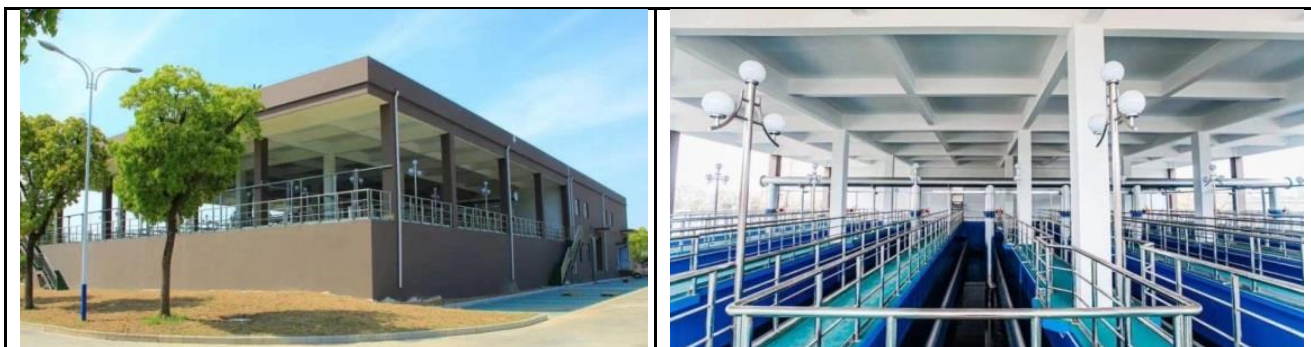
木渎新城污水处理厂 10000m 3 /d 提标改造项目
