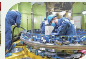
岩滩水电站运维人员清扫集电环碳粉
