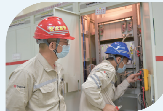
安全监督人员每日对各作业现场开展现场监督
