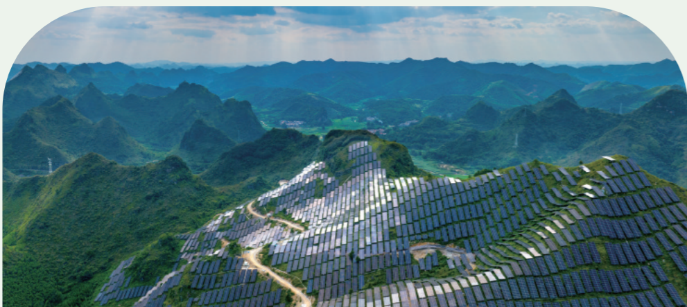
田东光伏项目
