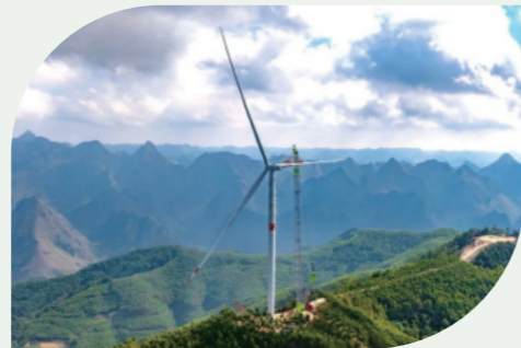
都阳风电项目首台风机吊装
