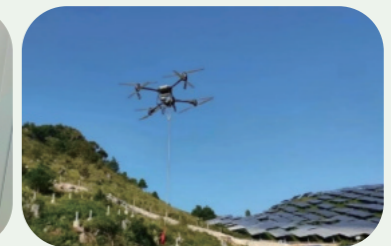
无人机运输光伏项目组件
