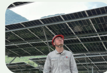
拉才光伏电站运维人员巡视设备
