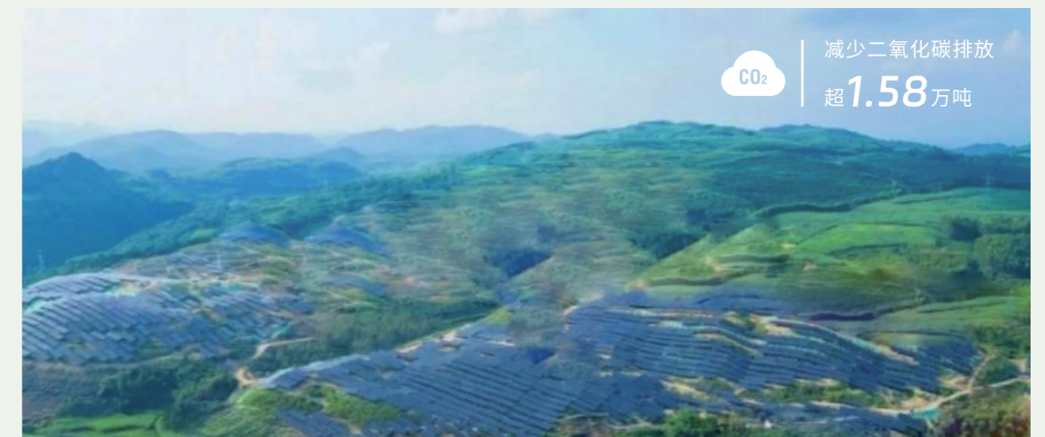
拉才光伏电站
