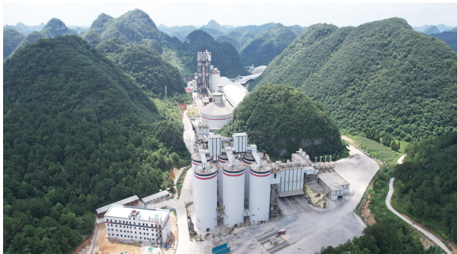
贵州独山日产4500吨新型干法水泥熟料生产线
