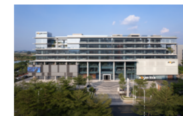
艾比森东江智造中心研发大楼，“会呼吸”的建筑
