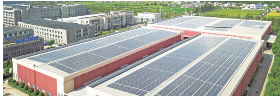
● 屋頂光伏太陽能—中國
