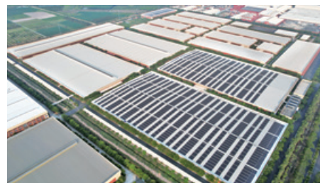
● 屋頂光伏太陽能—越南
