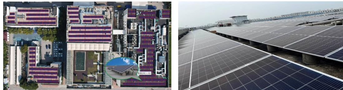
易德龙各栋楼顶铺设屋顶光伏
