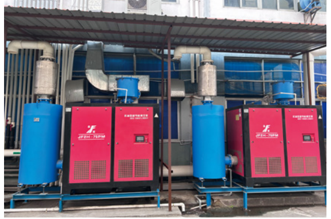
安装新通风换气设施
