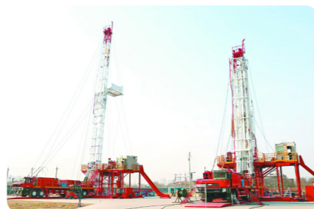
万米修井机在顺北区域作业
