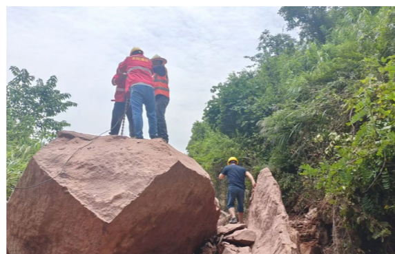
抢险施工现场
