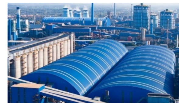
梅山基地封闭料场
