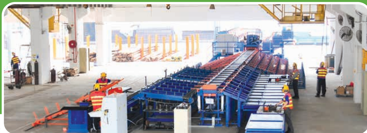
香港大埔之鋼筋自動化加工工場
