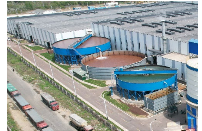
连云港公司废水循环利用车间
